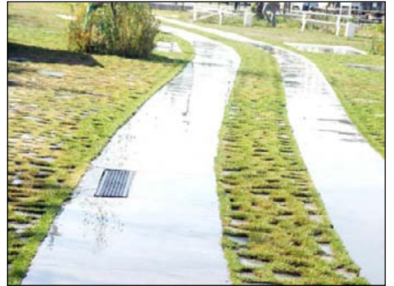
Principe de minéralisation minimale des voiries de desserte
