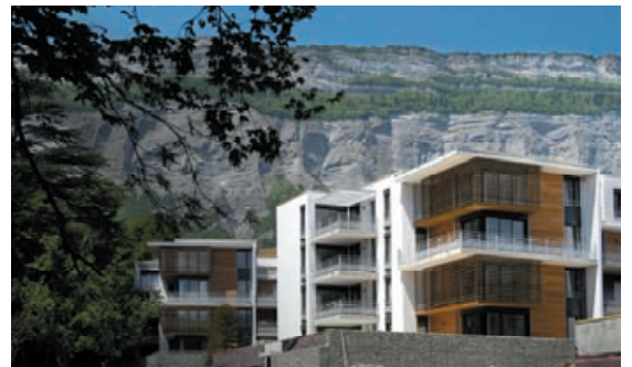
Le projet de la Praly à Meulan cache le surplus de stationnement avec des gabions qui forment terrasse pour les appartements du rez de chaussée
