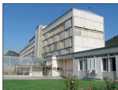
La Maison d'Arrêt de Varcès
