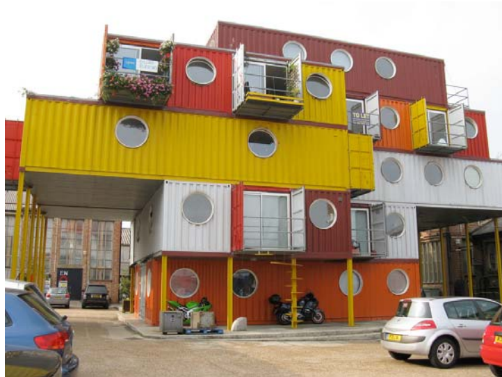
Container City à Londres : un quartier écologique et économique sur les docks.
